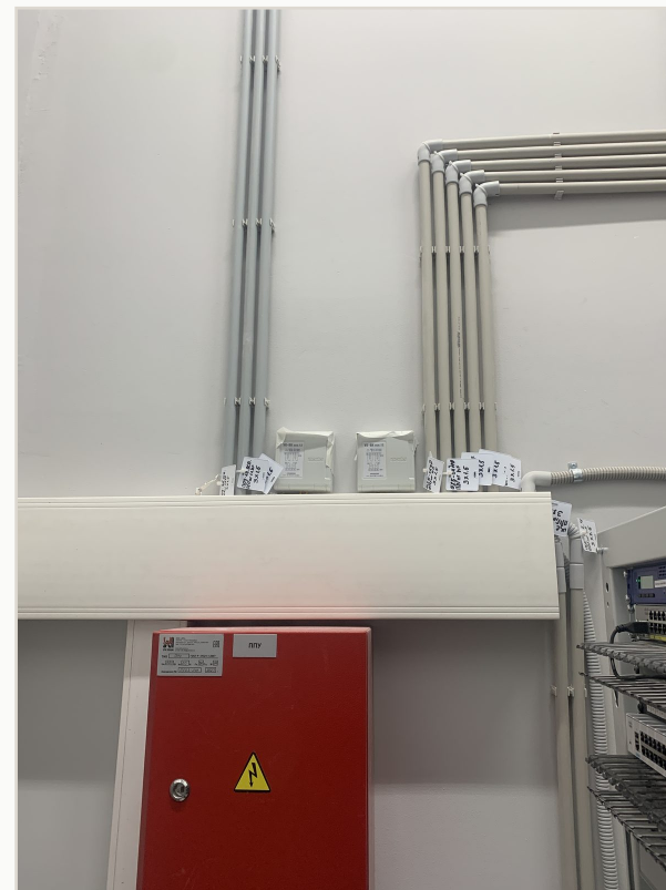
Монтаж щитовой и маркировка
