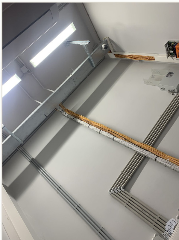
Прокладка кабельных трасс
